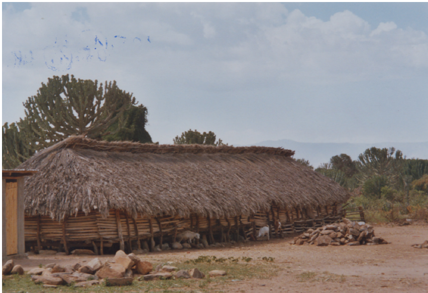
8. Cölöpökre épített iraku közösségi gabonaraktár, Mangola Chini, Tanzania, az Eyasi-tó környéke
